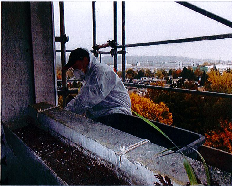
Die Sanierungsarbeiten sind bereits in vollem Gange: Hier werden vor dem Balkon der Steinbauers Asbest-Platten entfernt. Foto: privat
