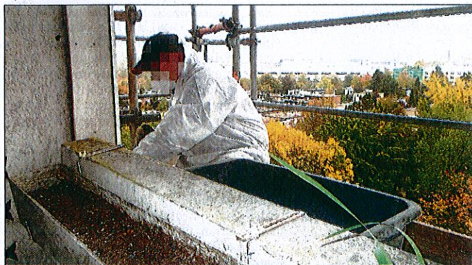
Die Arbeiten an Strang A der Kurt-Schumacher-Straße 23 sind in vollem Gang, während das Ehepaar Steinbauer noch in der Wohnung lebt. Eine Ausweichwohnung haben sie bislang nicht bezogen. (Foto: Steinbauer)
