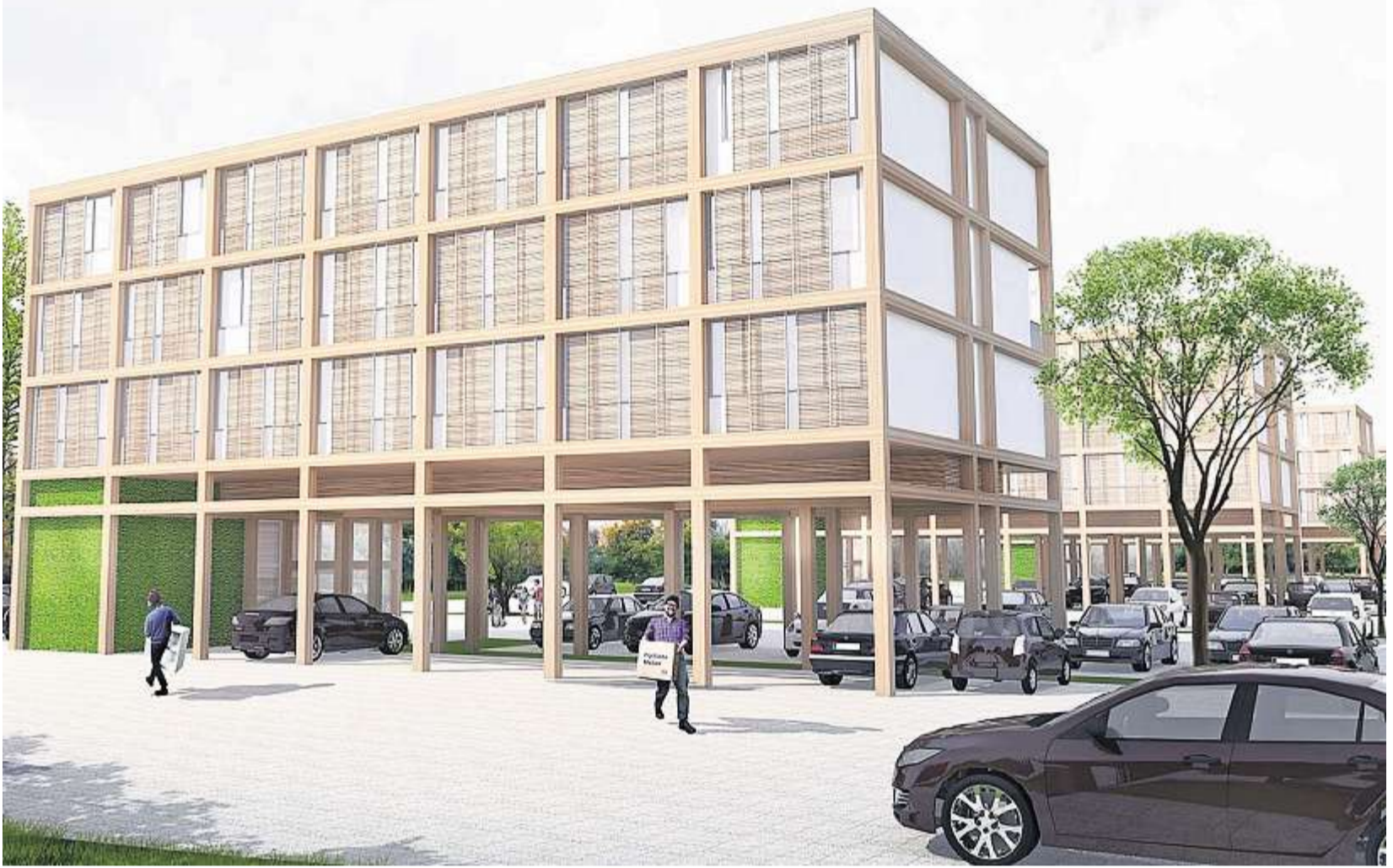
Stelzenhäuser in Holzbauweise auf Parkplätze stellen – das ist das „Koblenzer Modell“.
