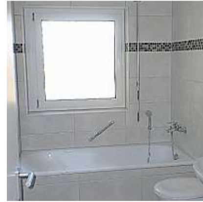
Komplett saniert sieht das Bad gleich ganz anders aus.
