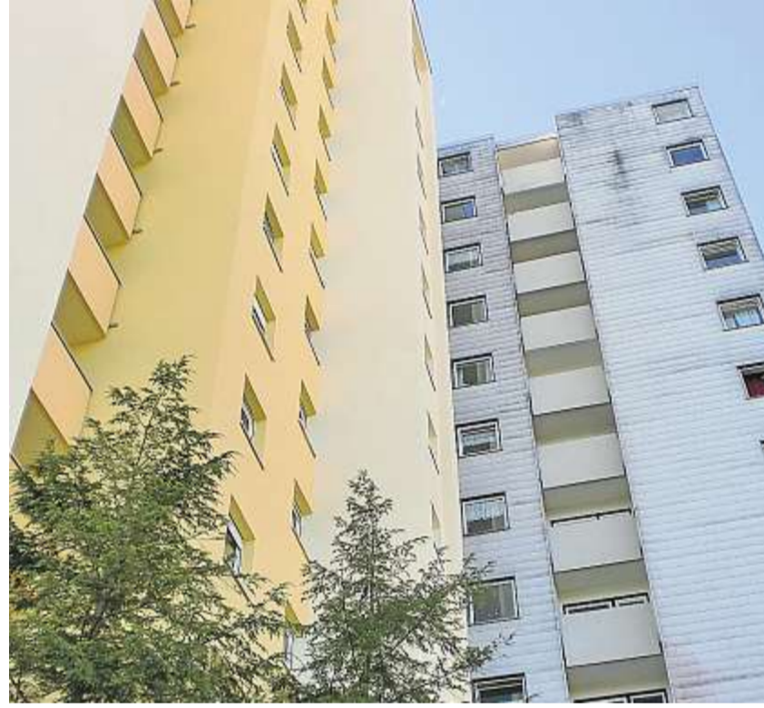
Von außen sieht man den Unterschied sofort: links der sanierte, rechts der unsanierte Gebäudeteil
