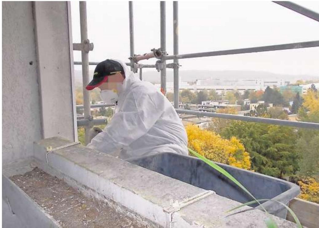
12. Oktober, 12.45 Uhr, am Balkon von Dr. Steinbauer: Arbeiter im Schutzanzug entfernen die Eternitplatten, die Asbest enthalten. Dabei gehen viele Platten zu Bruch. Foto: Dr. M. Steinbauer
