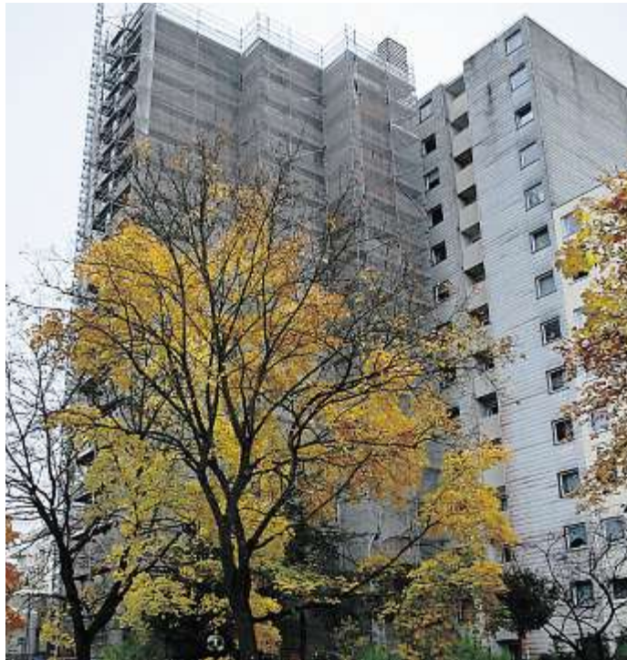
Das Stadtbau-Haus in der Kurt-Schumacher-Straße wird derzeit aufwendig saniert.
