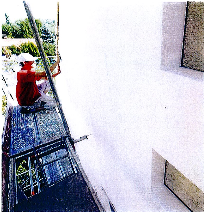
Styroporplatten zur Wärmedämmung werden an einer Fassade befestigt.
