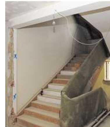
Der Treppenaufgang ist fast fertig.
