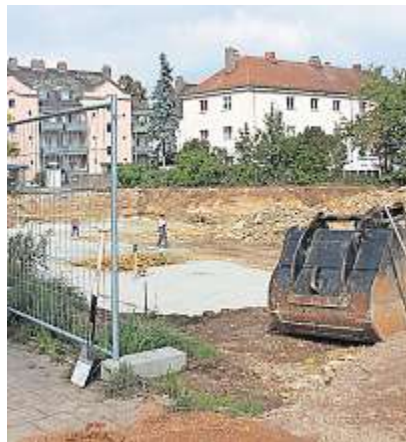
Die Baustelle an der Plato-Wild-Straße/Ecke Runtingerstraße
