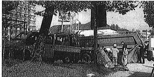
Im Oktober wurde eine 73-Jährige direkt an der Baustellenzufahrt von einem Lkw überrollt. Sie ging am Bürgersteig.
