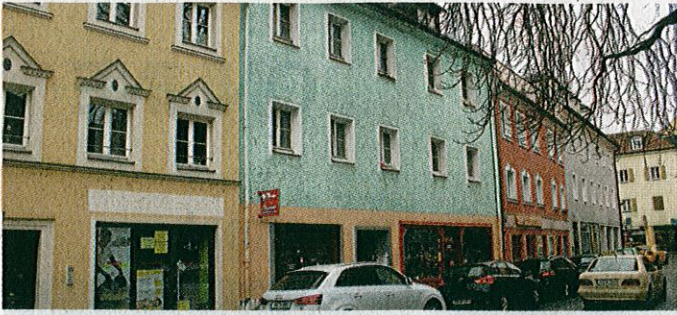
Horror-Haus in der Grasgasse: Weil sie keine Kühlschränke haben, lagern die Bewohner Lebensmittel auf dem Fenstersims.
