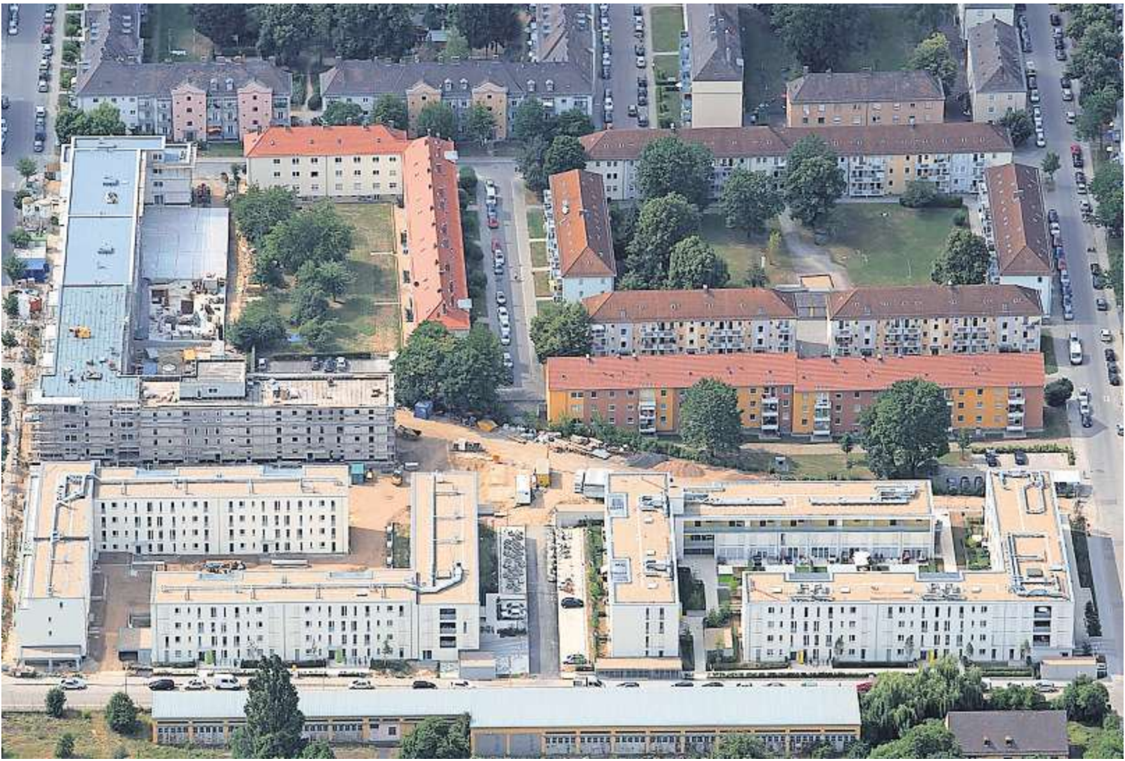
Am Mittwoch wurde das neue Wohnquartier in der Daimlerstraße für rund 500 Bürger bei einer Pressekonferenz offiziell vorgestellt. Foto: Herbert Stolz
