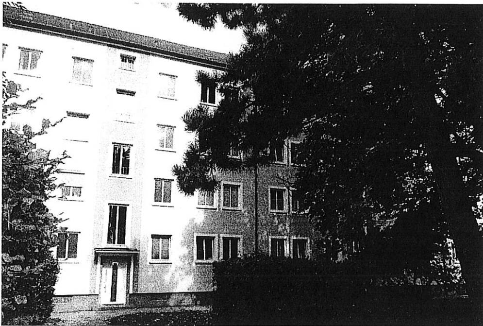
Grüner Innenhof, renovierte Fassade, neue Fenster und Dächer: für die Stadt Regensburg „nicht wirtschaftlich“, ein privater Investor machte innerhalb eines Jahres über 60 Prozent Rendite. Foto: as
