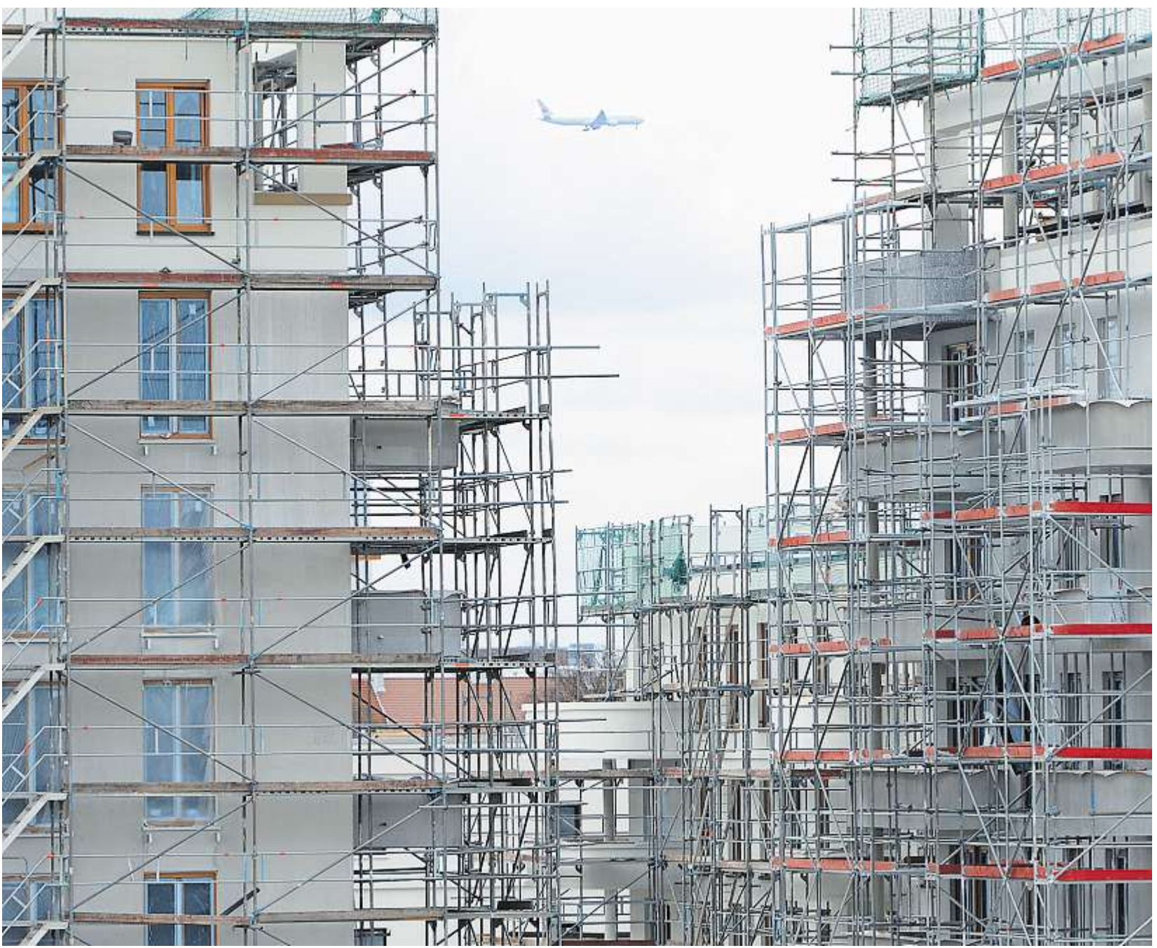
Eingerüstete Wohnhäuser in einem Neubaugebiet: In manchen Städten kann die Planung und Genehmigung großer Projekte Jahre dauern.
