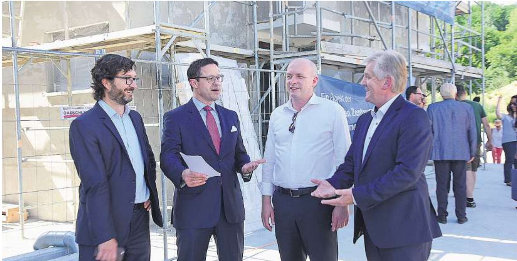
Oberbürgermeister Joachim Wolbergs mit Ulrich Berger (l.), Wolfgang Herzog (2. v. re.) vom Immobilien Zentrum und Franz Bauer (r.), Geschäftsführer der Siwo-Bau, beim Richtfest in der Michelerstraße in Schwabelweis
