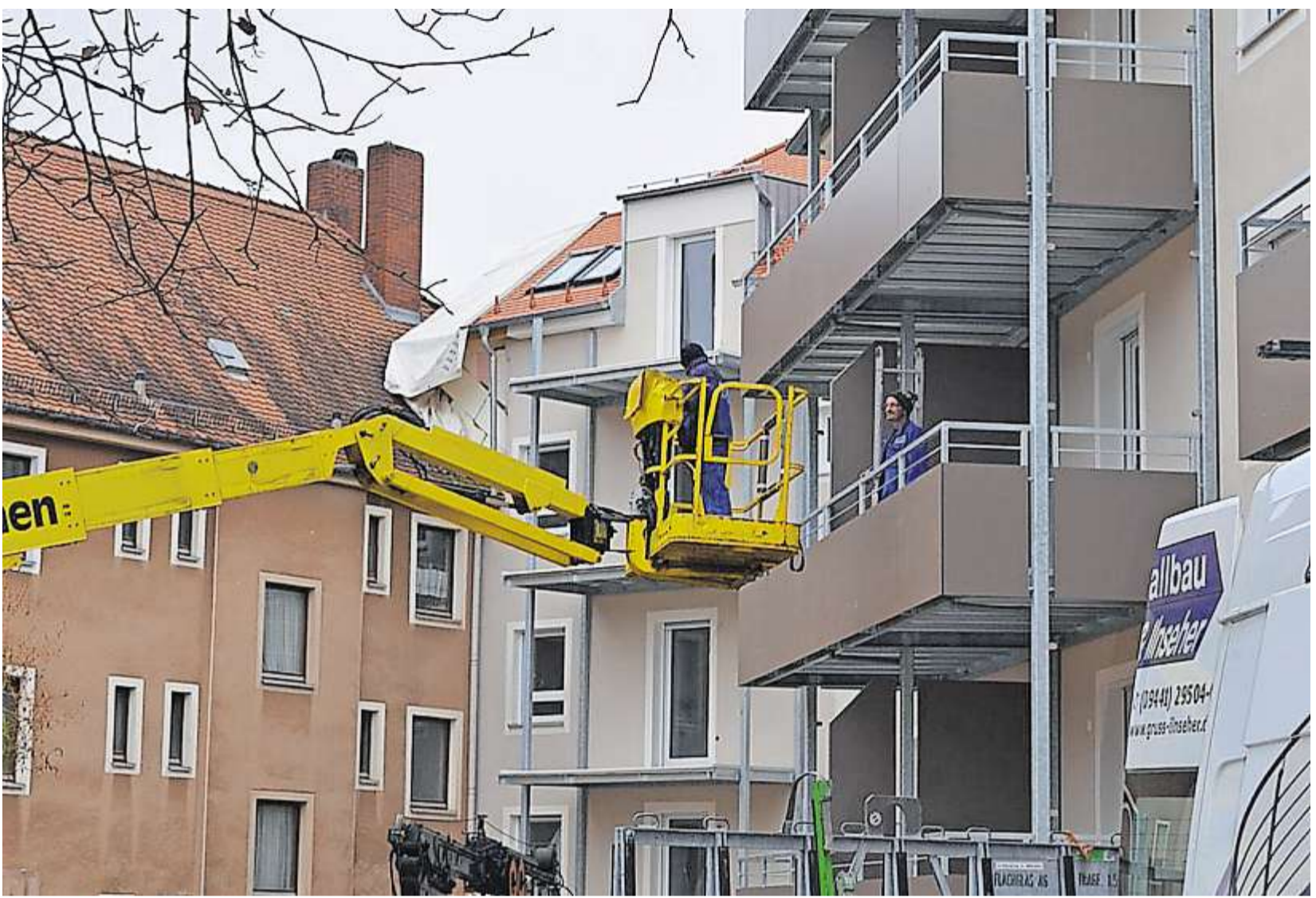
Genossenschaftswohnungen in der Bischof-Wittmann-Straße: Dort saniert die Wohnbau St. Wolfgang. Sie würde gerne neu bauen, doch um ihre günstigen Mieten halten zu können, bräuhete sie preisgünstige Flächen. Fotos: Koller, Nabau, Geradtz, Hinreiner, Werkvolk
