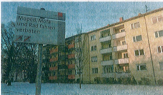
Wohnanlage der Stadtbau in der Altdorferstraße im Inneren Westen: Notunterkünfte kommen hier rein. Foto: Eckl
