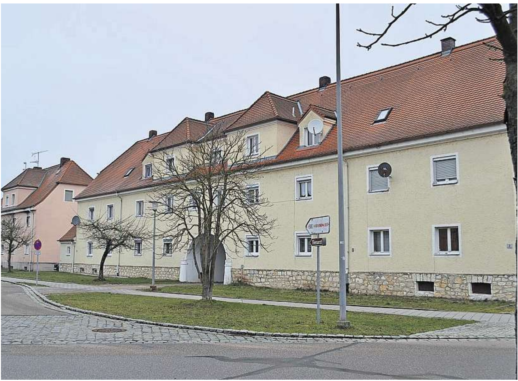
Für die Sozialwohnungen zwischen Schwandorfer Straße und Hans-Sachs-Straße soll es ein städtebauliches Gesamtkonzept geben. Foto: Norgall
