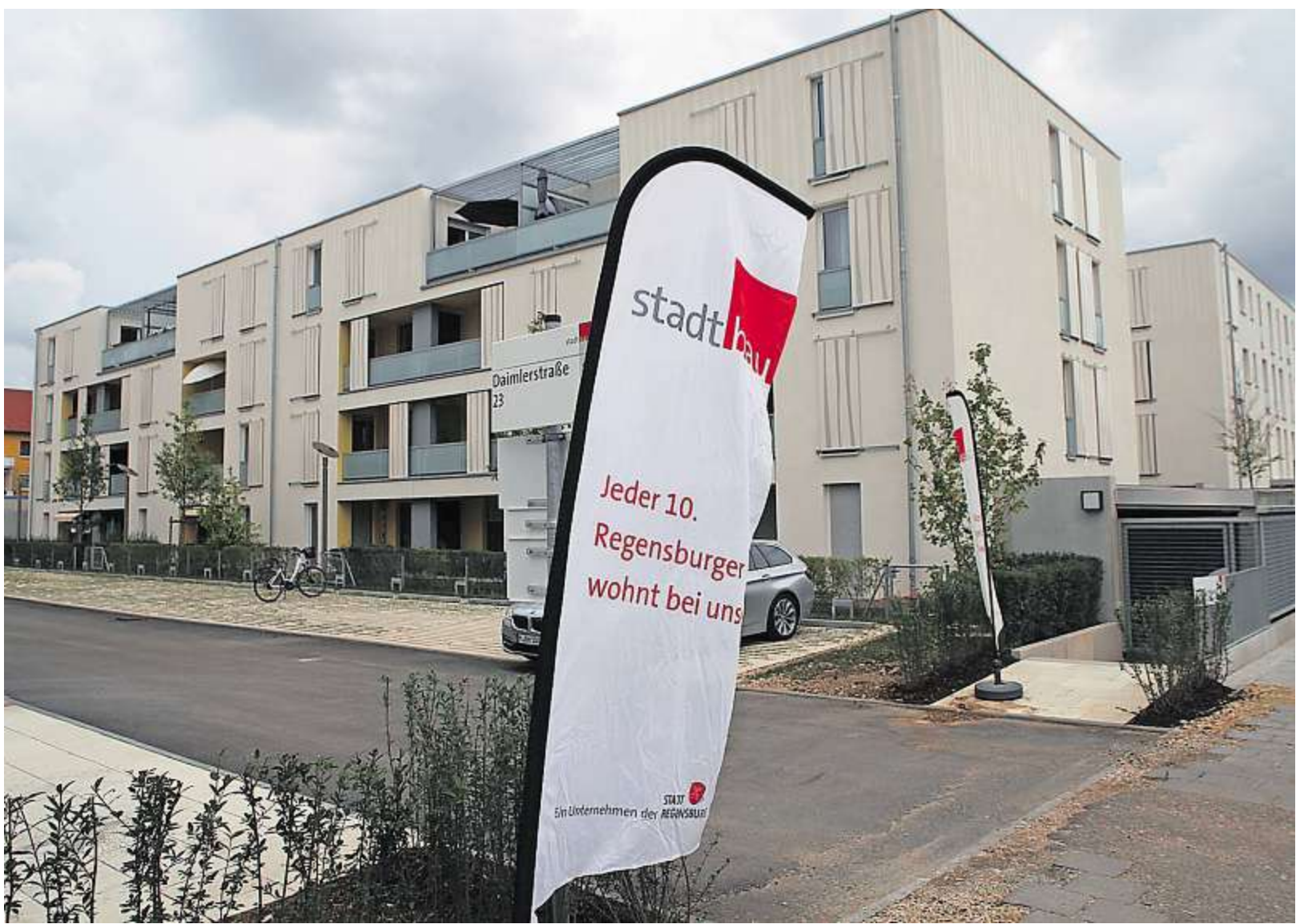
Die Stadtbau bietet Tausende Wohnungen. Ist bei der Bestellung des neuen Technischen Leiters alles mit rechten Dingen gelaufen?
