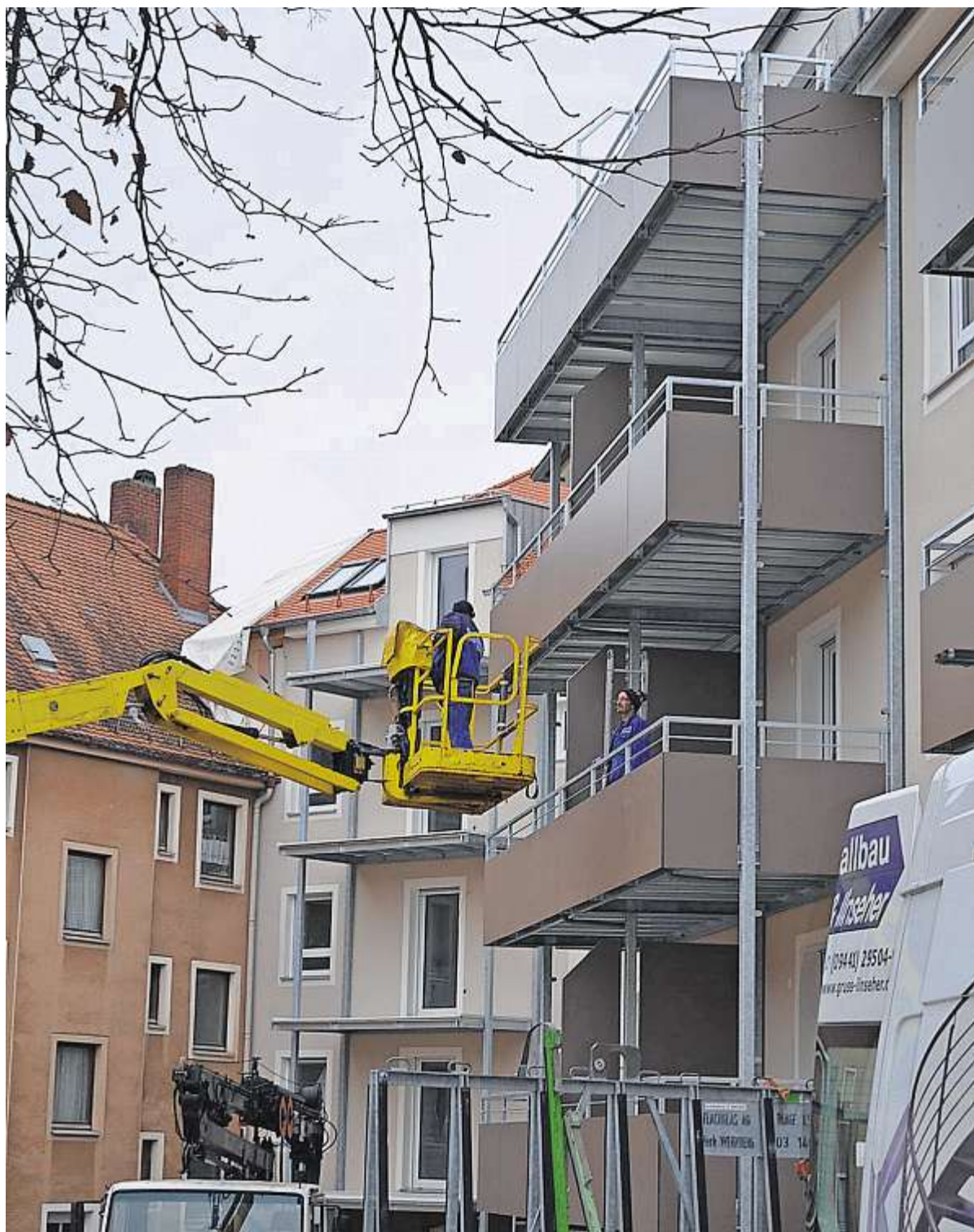
In der Bischof-Wittmann-Straße saniert die Wohnbau St. Wolfgang den Bestand, günstige Grundstücke bekommt sie nicht. Foto: Koller
