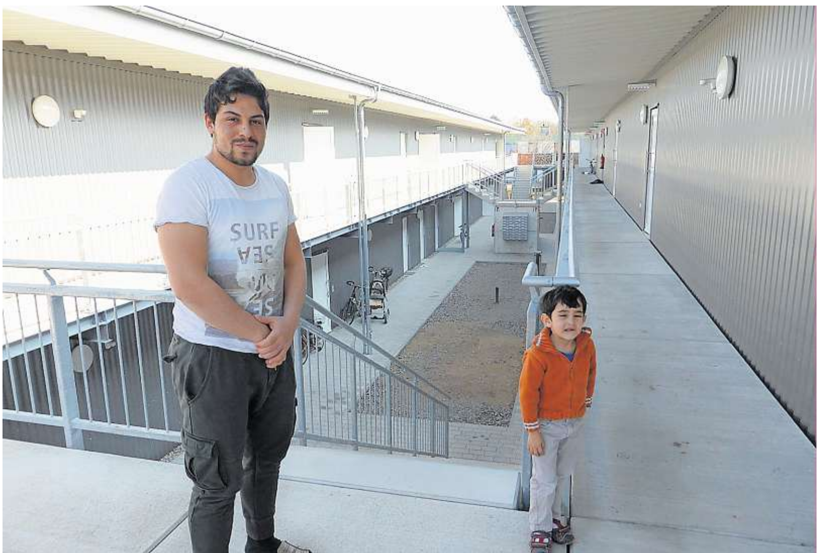
Die Flüchtlingsunterkunft am Weinweg ist in Modulbauweise entstanden. Für eine Nachnutzung kommen auch andere Personengruppen infrage. Foto: Stadt
