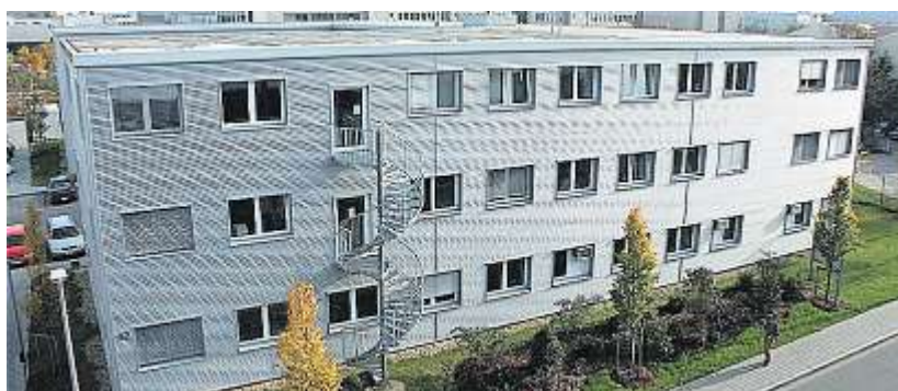
Ein Beispiel für schnelle, nachhaltige Modulbauweise: Im Businesspark Regensburg wuchs schon 1999 dieses Bürogebäude mit 3600 Quadratmetern Nutzfläche in nur 57 Arbeitstagen aus dem Boden. Foto: Strunz Systembau
