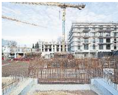
Bautätigkeit in der ehemaligen Nibelungenkaserne Foto: Stadtbau
