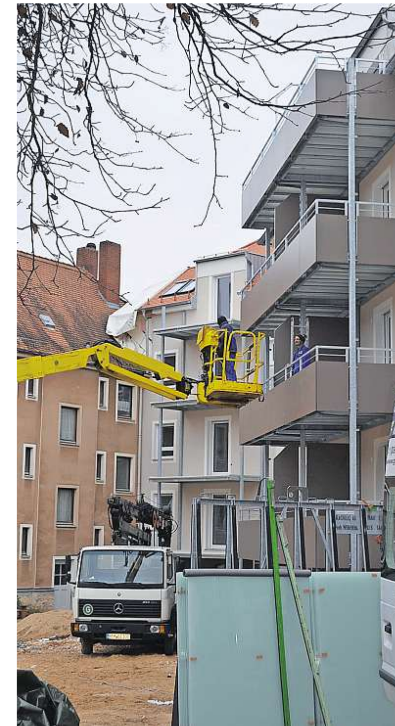
Zuletzt nahm die Wohnbau St. Wolfgang umfangreiche Sanierungen in Angriff – wie hier an der Bischof-Wittmann-Straße.
