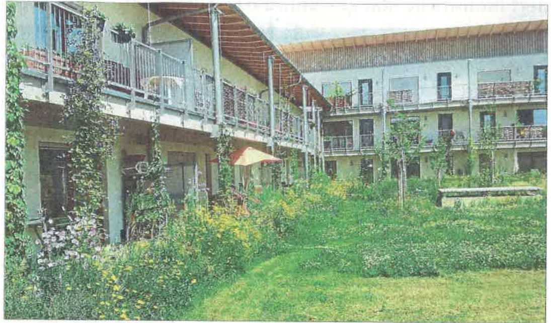
Für ihr „Haus mit Zukunft“ in Burgweinting hat die NaBau eG 2016 den Umweltpreis der Stadt Regensburg verliehen bekommen. Foto: NaBau
