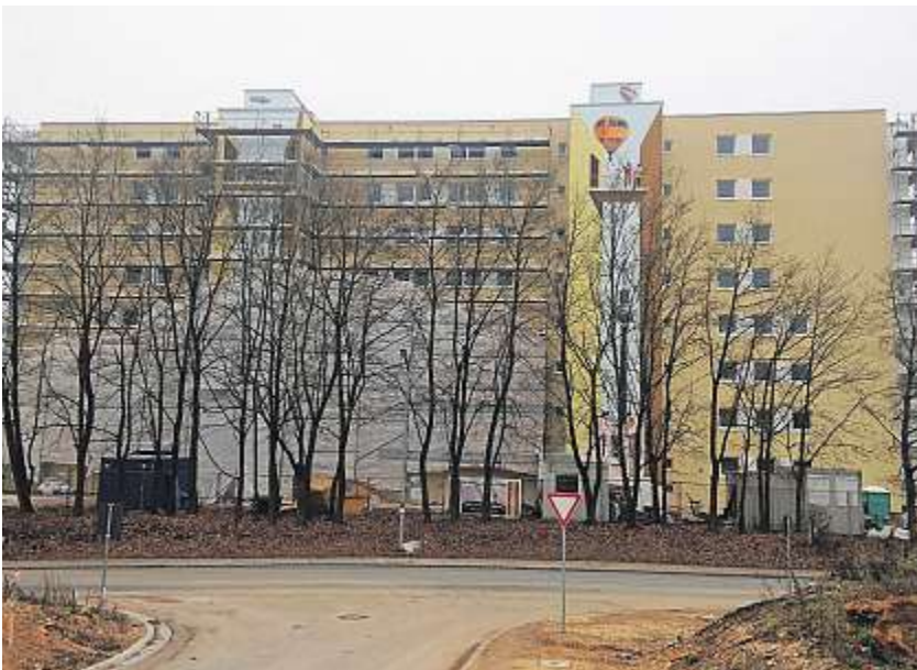
Eine der großen Stadtbau-Liegenschaften: die Berliner Straße 41 und 43 während der Sanierung Foto: Stadtbau
