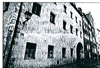
... und nach der Sanierung. Fotos: NÜ
