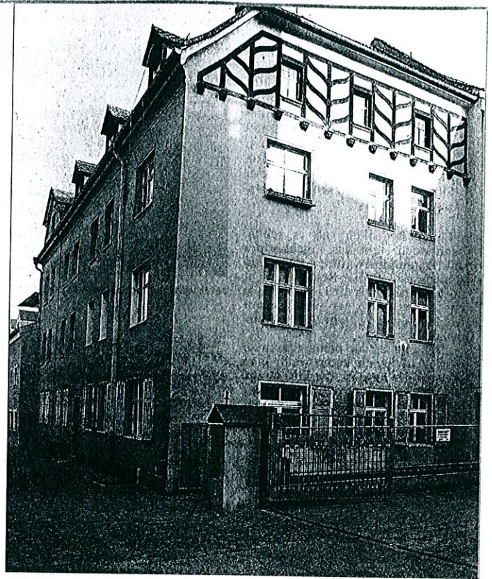
In den beiden Objekten in der Nähe der Ostengasse sollen insgesamt elf sanierte Wohnungen geschaffen werden.
