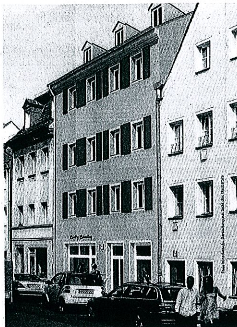
Am PC schon fertig: das Haus Ostengasse 23
