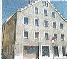
Diesem Haus in der Ostengasse steht der Abriss bevor.
